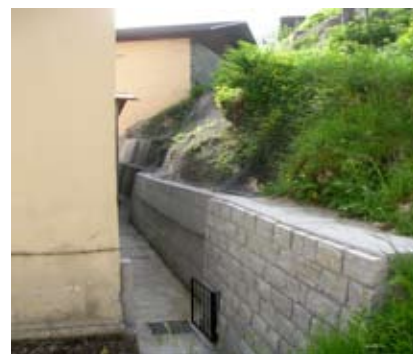
Intervento retro chiesa
