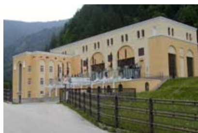
Vista dell'esterno della centrale di Caoria
