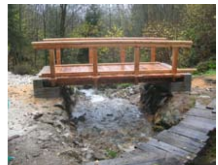
Passerella in costruzione
