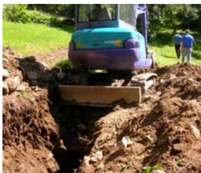
Lavori della squadra comunale
