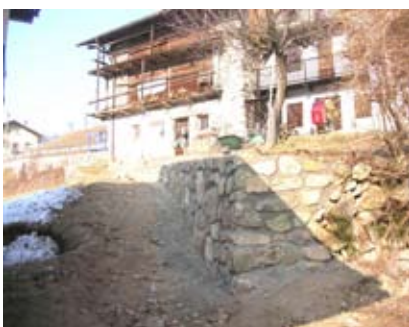
Lavori della squadra comunale
