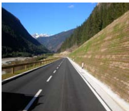
S.P. 56 nuovo tratto
