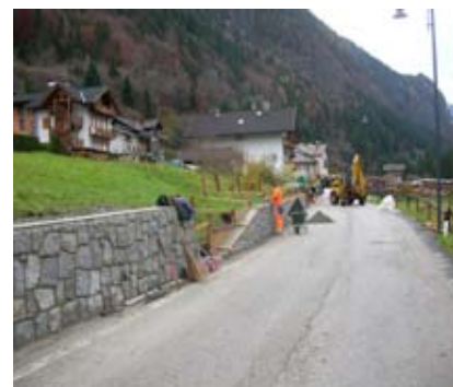
Lavori della squadra comunale
